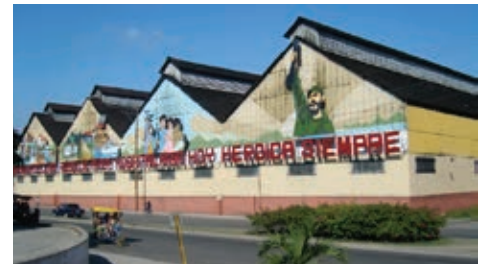
Figura 13: Ron Bacardí. Edificio Don Pancho para añejamiento.
