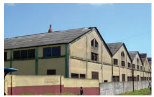
Figura 17: Fábrica de Cervezas Hatuey. Naves industriales.
