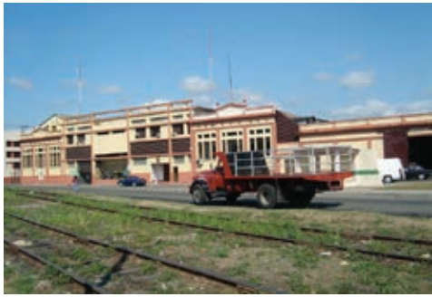
Figura 10: Ron Bacardí. Edificio para la destilería. Arq. Gerardo Vega. Ecléctico. En 1955 se realiza un proyecto de ampliación por los Arqs. Ermina Odoardo y Ricardo Eguilior incorporando expresión racionalista al centro de la fachada.
