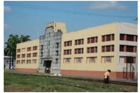
Figura 12: Ron Bacardí. Edificio para planta de rectificación. Arq. Gerardo Vega. Con expresión racionalista y monumental moderno.
