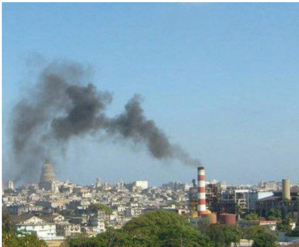
Figura 1: Proximidad de las fuentes contaminantes a los monumentos. Fuente: Autor, 2014
