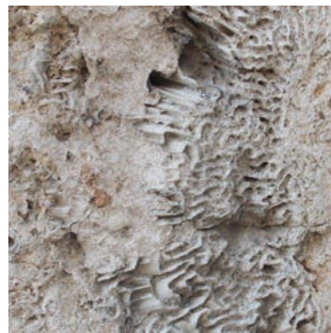
Figura 3: Presencia de conchas y otros restos marinos en la piedra utilizada. Fuente: Autor, 2014
