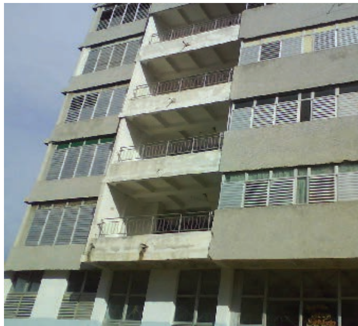
Figura 3: Edificio de viviendas con sistema IMS. Fuente: Autores.
