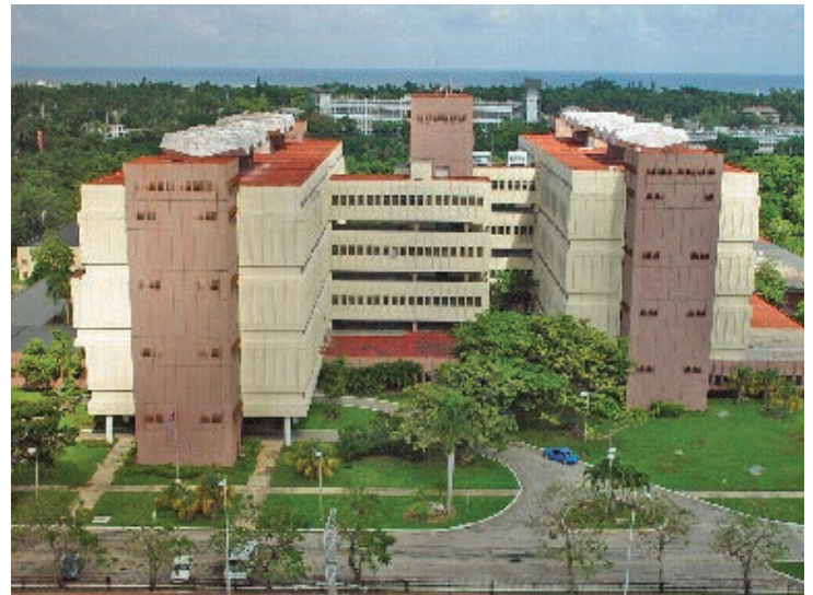
Figura 5: Centro de Ingeniería Genética y Biotecnología. Edificación con sistema SMAC en el que las uniones viga-columna se basan en el efecto cuña. Fuente: Internet.
