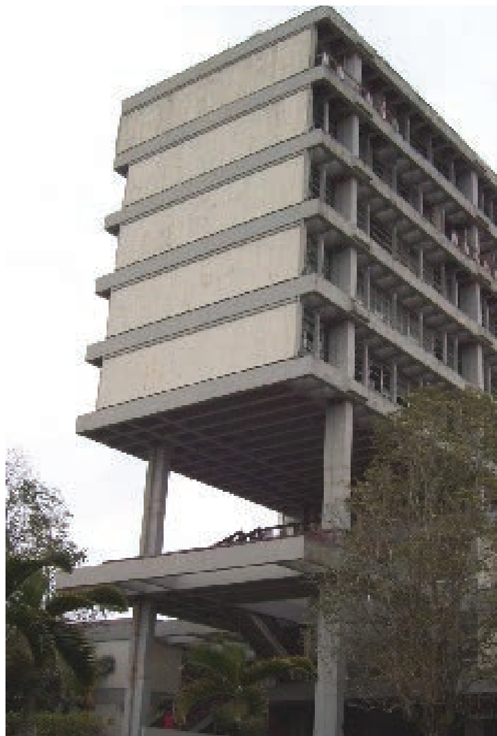
Figura 7: Instituto Superior Politécnico "José A. Echeverría". Sistema Losa-izada con uniones viga-columna por fricción mediante cuñas metálicas. Fuente: Elaboración propia.
