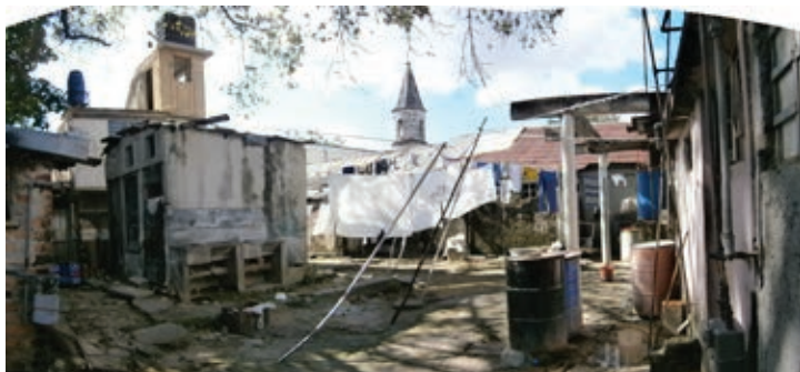
Figura 7: Casa de vecindad en San Salvador no. 428, El Canal, La Habana.
