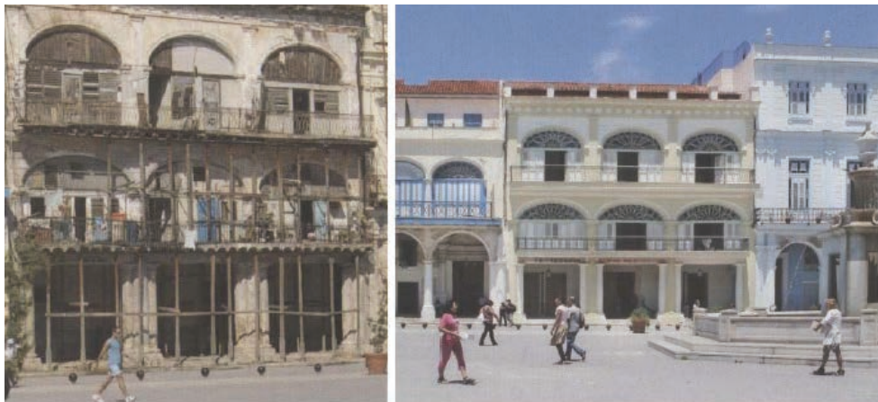
Figura 5: Casa de vecindad en San Ignacio 360 rehabilitada por la OHC. Fuente: Autores varios. La Plaza Vieja de La Habana. Proceso de recuperación. Sevilla: Junta de Andalucía.
